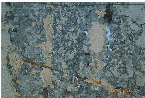
სურ. 13. განშრეკებული ბეტონის ზედაპირი და კოროზირებული არმატურა
