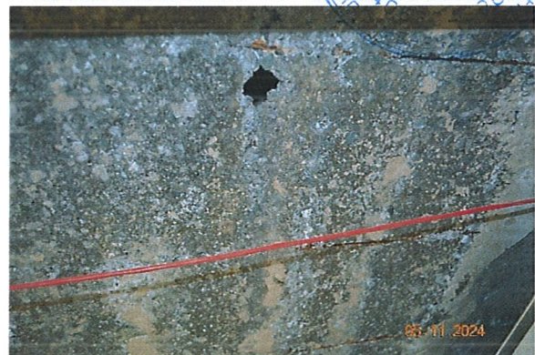
სურ. 14. განშრეკებული და ჩამოშლილი ბეტონის ზედაპირი
