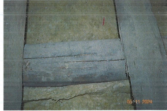
სურ. 18 ნახეთქი ბზარები გადახურვის ხის კოჭებზე
