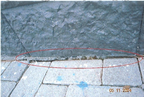
სურ. 7. დაცილება მზიდ კედელსა და მოსაპრკეთებელ ფილებს შორის
