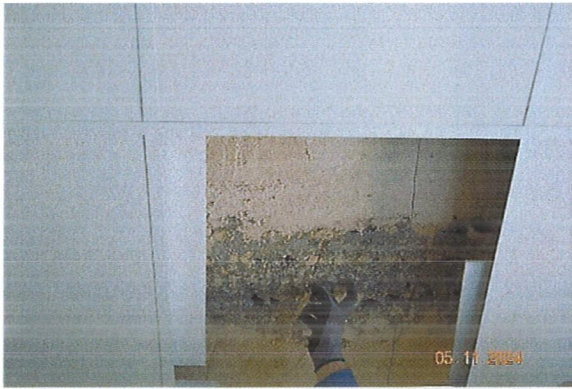
სურ. 15. განშრევებული ბეტონის ზედაპირი და კოროზირებული არმირება
