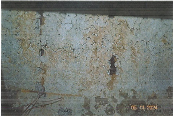
სურ. 43. განშრევებული ბეტონის ზედაპირი და კოროზირებული არმირება
