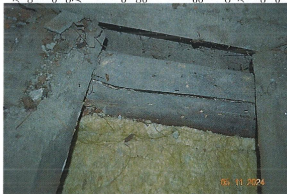
სურ. 21. ნახეთქი ბზარები გადახურვის ხის კოჭებზე
