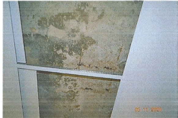
სურ. 44. განშრევებული ბეტონის ზედაპირი და კოროზირებული არმირება
