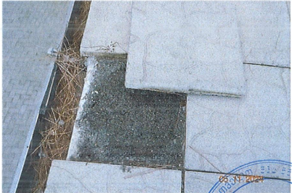
სურ.46.დეფექტურად ჩამაგრებული მოსაპირკეთებელი ფილა
