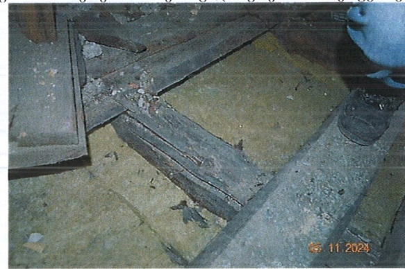
სურ. 20 ნახეთქი ბზარები გადახურვის ხის კოჭებზე
